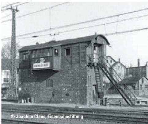
Bei dem Behelfsstellwerk „Hnf“ in Hanau Hbf handelte es sich um den Wagenkasten eines ehemaligen MCi, den man auf einen gemauerten Sockel gesetzt hatte. Behelfsstellwerke blieben – obwohl nur als kurzfristiges Provisorium gedacht – teilweise bis weit in die 1960er-Jahre bestehen.
